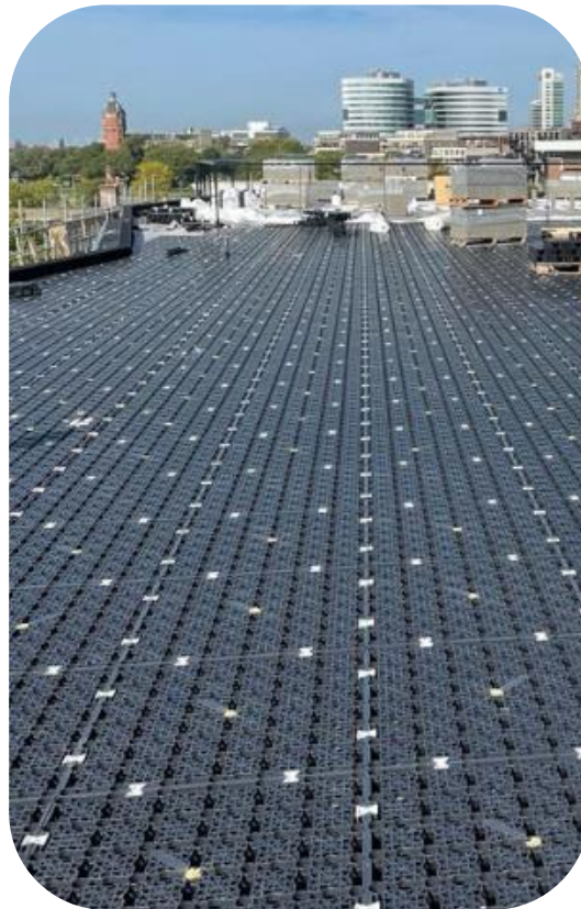
Voorbeeld van een gekoppelde retentievloer.
