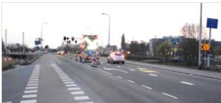
Figuur 3.1: Ook op de Goejanverwelledijk was één rijstrook afgekruid
