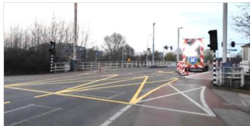
Figuur 2.4: Met tijdelijke belijning en een pijlwagen is één rijstrook afgekruid
