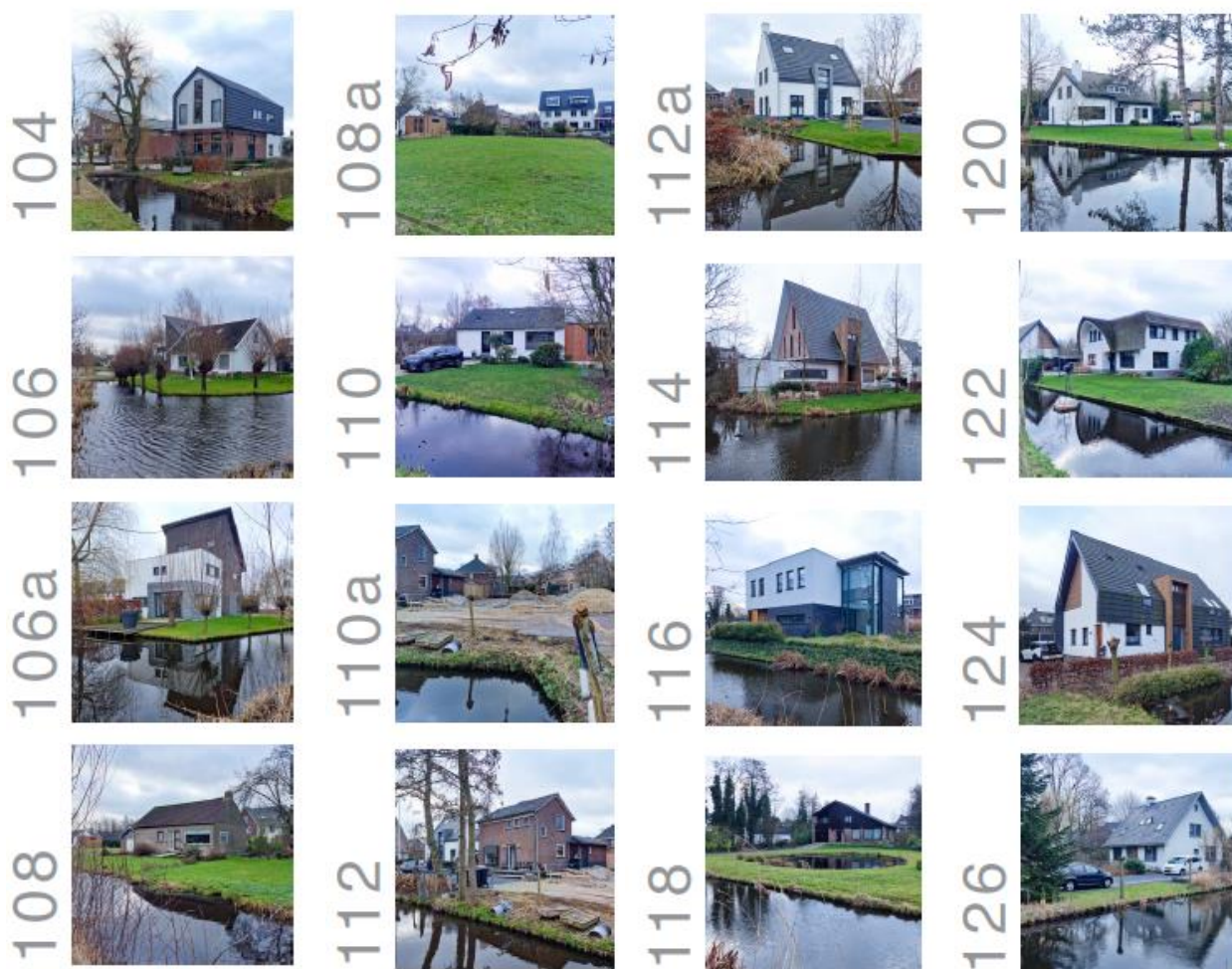
Overzicht van woningen aan de Achterwillenseweg Foto's: Kokon architecten
