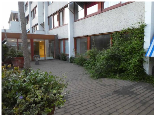
Figuur 7: De binnenplaats
