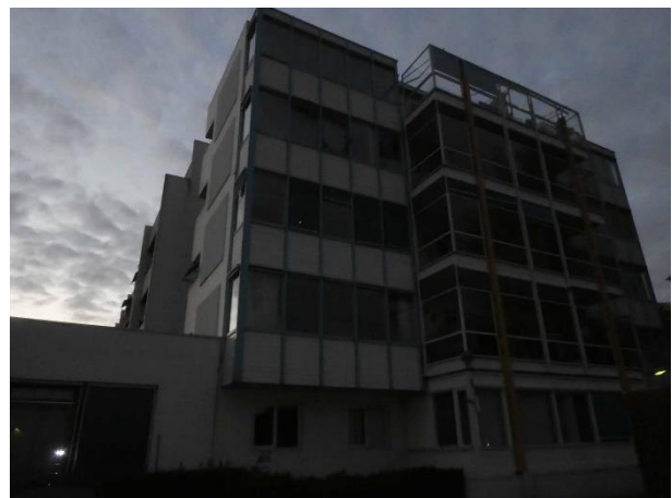
Figuur 4: Het voormalig verpleeghuis vanuit het zuiden gezien
