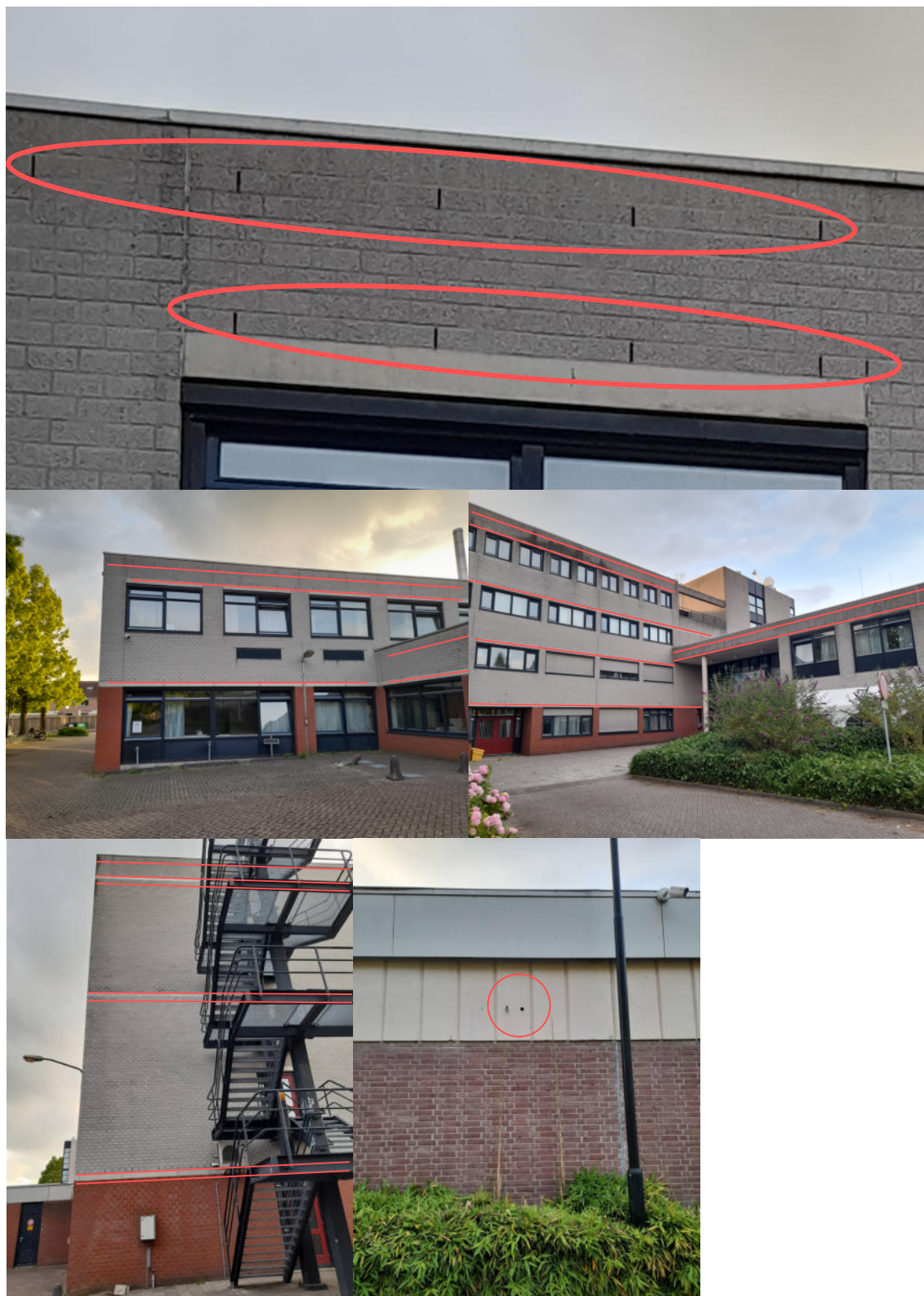
Figuur 3.4: Stootvoegen in kazernegebouw
